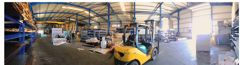
Πανοραμική λήψη, εσωτερικό του κτηρίου. Χώρος εργασιών. Άποψη από βόρεια.
